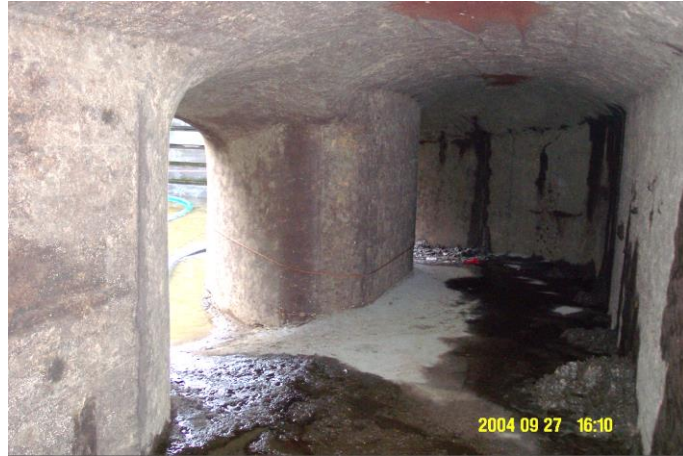
Figure 9 : égout de dérivation de l'écluse d'Hal
