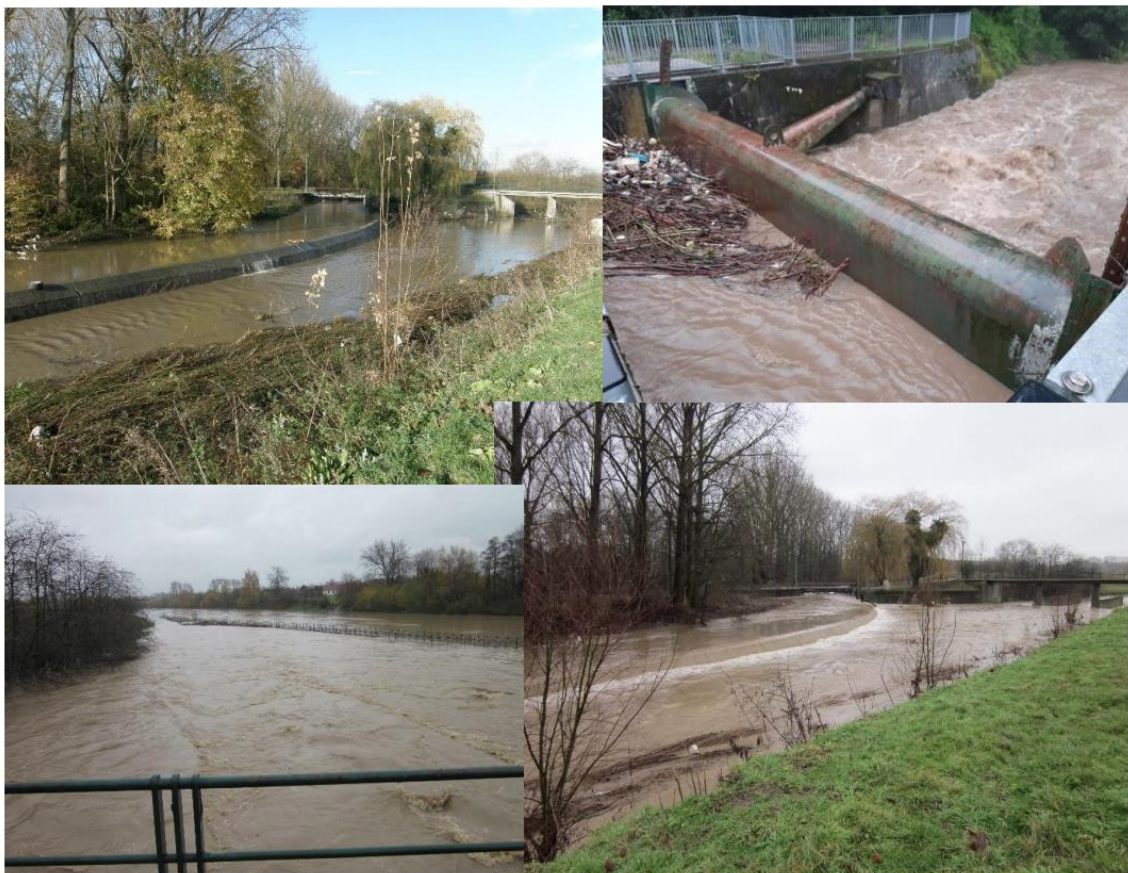
Figure 6 : photos de la vanne radiale et du déversoir à Lembeek à des débits élevés, montrant le fonctionnement de la vanne et du déversoir
